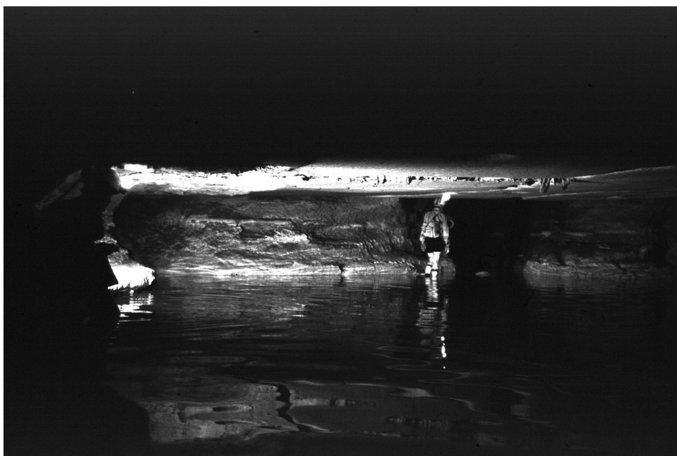
Fig. 1 - Tratto iniziale della galleria
