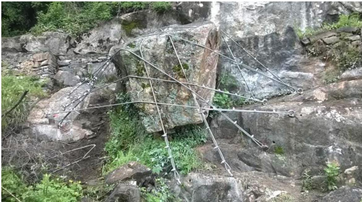
Fig. 5 Messa in sicurezza di un blocco con l'esecuzione di chiodature e legature con funi d'acciaio
