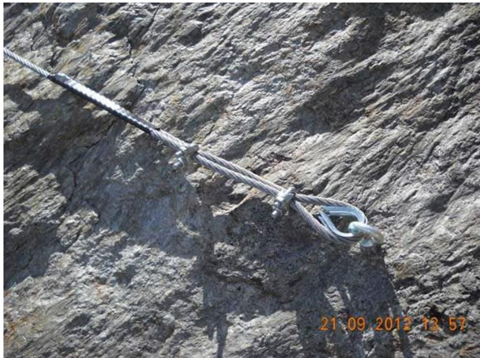
Fig. 6 Corde fisse di protezione per gli operatori
