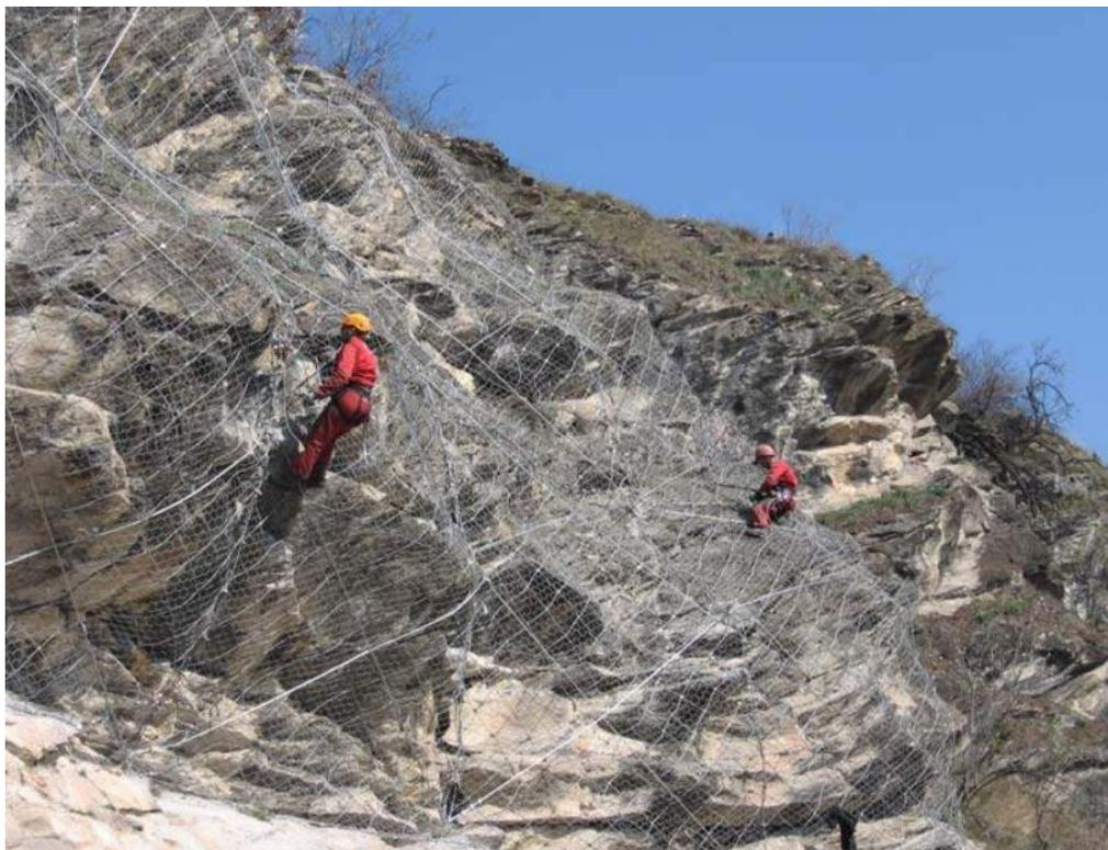
Figura 4 Posizionamento di sistemi di rivestimento con rafforzamento
