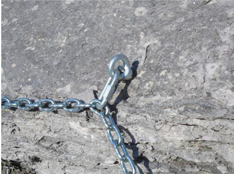
Fig. 7 Frazionamento di una catena di protezione
