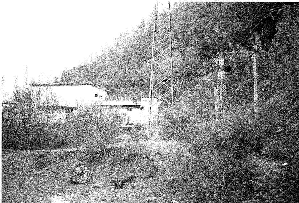
Fig. 11 - L'impianto di captazione della Sorgente Ceraso con le macro-forme carsiche adiacenti.
